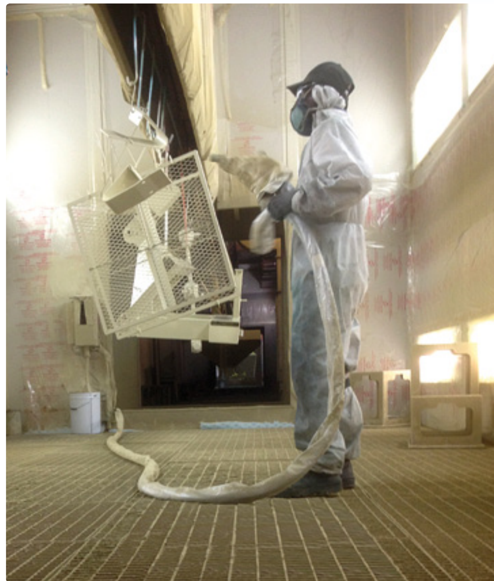
Druga warstwa chroniąca przed korozją i powłoka wykańczająca
